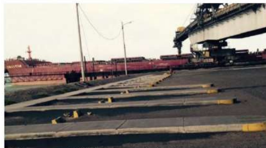
Foto 2. Zona de parqueo debidamente delimitada para equipos livianos y medianos. Zona obligada de parqueo en el área del cargador de buques
