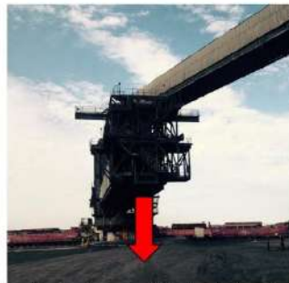
Foto 1. No está permitido el tránsito por debajo de la cola del cargador de buques. Se pueden generar derrames de carbón por falla mecánica de frenos.
