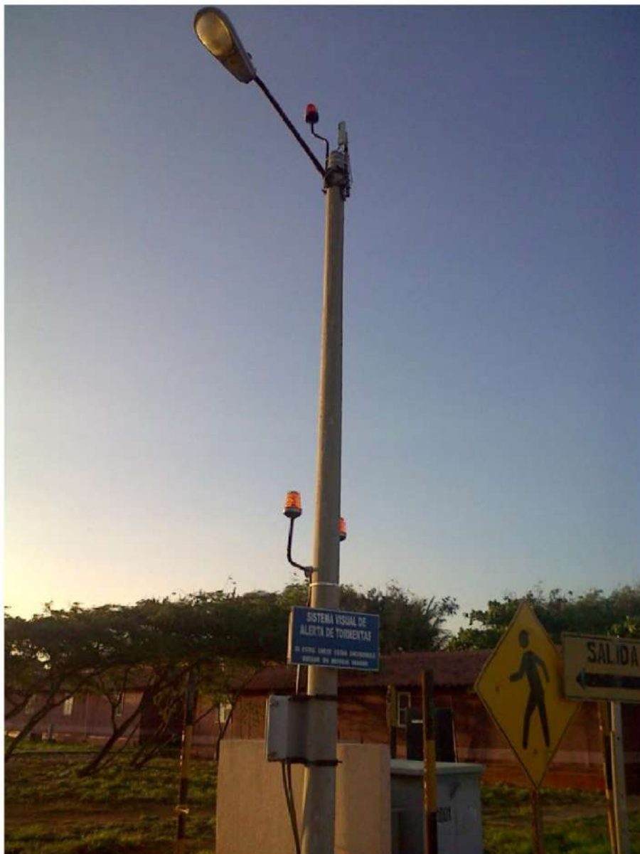
Nota: Poste con tres luces indicadoras de alerta de tormentas eléctricas en el Campamento.
